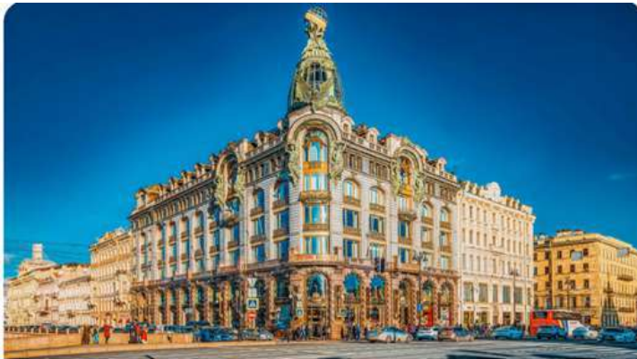
L'immeuble Art Nouveau de la société de machines à coudre « Singer » à Saint-Pétersbourg
